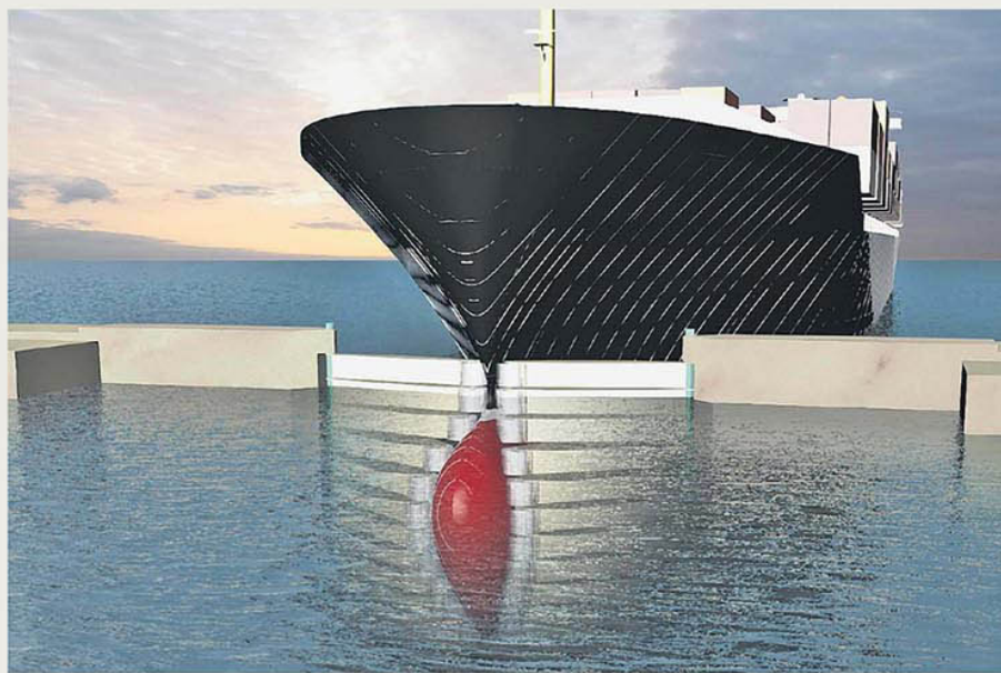
Lamellen in de sluisdeur van het ontwerp van de Locky Sirens volgen de contouren van de scheepswand.
